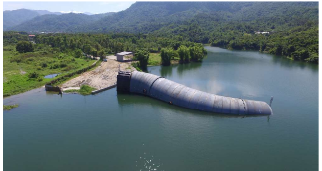
▲ 曾文水庫防淤隧道象鼻引水鋼管拖曳前。
