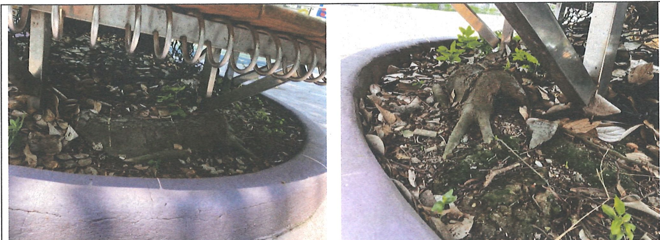
座椅的水泥基座設置於樹穴內，樹木生長空間不足造成盤根；根系有切斷痕跡
